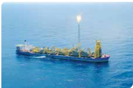
Início da produção do projeto Pré-Sal de Baleia Azul, por meio do FPSO Cidade de Anchieta. Essa plataforma, do tipo FPSO é uma unidade flutuante que produz, armazena e exporta óleo e gás
